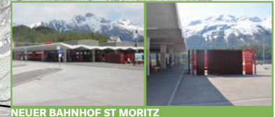
NEUER BAHNHOF ST MORITZ
