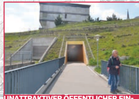
UNATTRAKTIVER ÖFFENTLICHER EINGANG TIEFGARAGE
