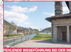
FEHLENDE WEGEFÜHRUNG BEI DER INN
